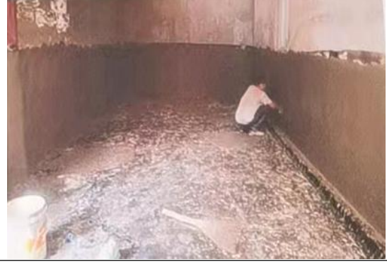
危废间防水砂浆
